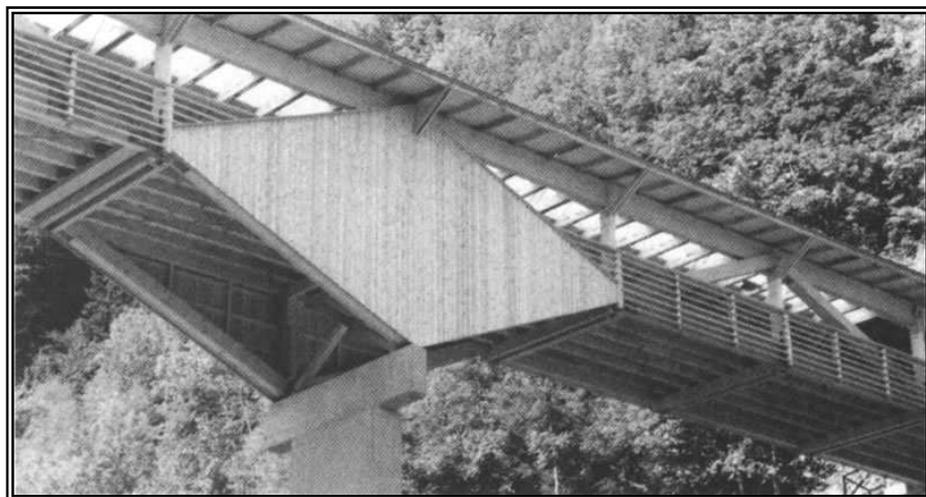
Figura 8: Particolare dell'appoggio della struttura principale sulla pila.
