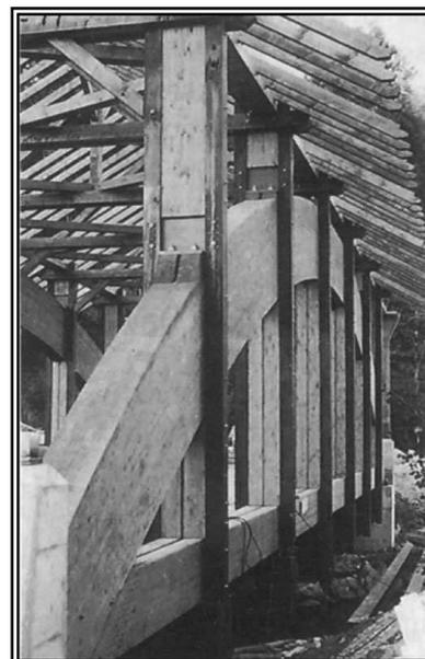
Figura 25: Particolare della travata ad arco.
