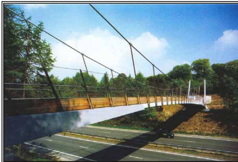
Figura 4: Vista del sottile impalcato in fibra con plastica rinforzata (GRF).
