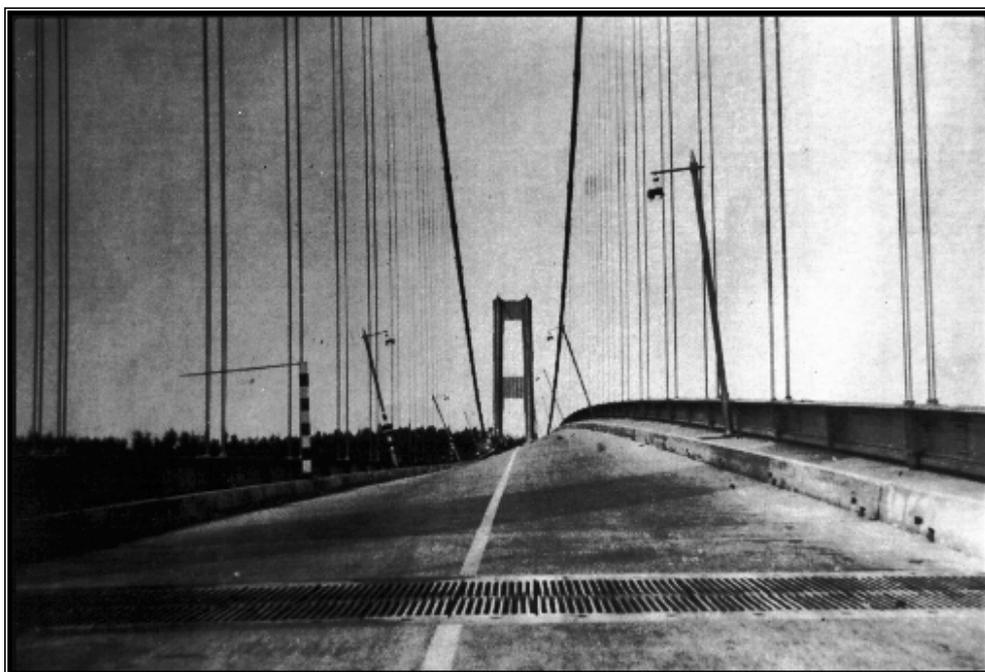
Figura 15: Vista delle oscillazioni del ponte Tacoma-Narrows Bridge, prima del collasso, da sopra l'impalcato.
