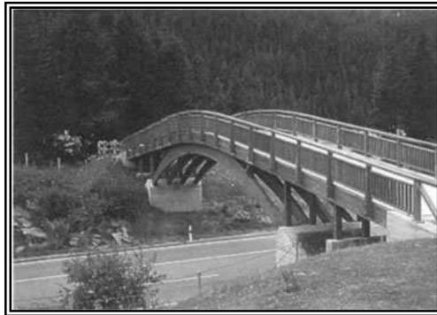
Figura 7: Ponte con struttura a catenaria.
