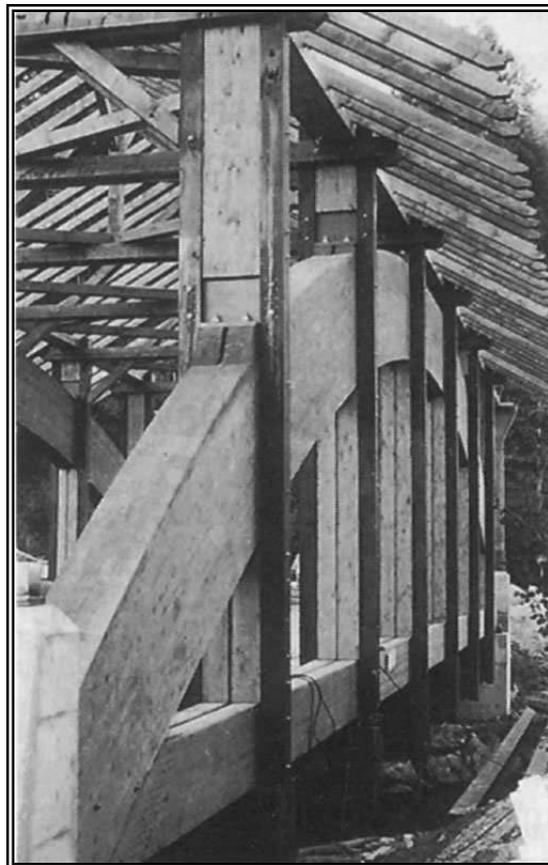
struttura. Se non era presente la struttura ad arco questa spesso era sostituita da un cavalletto portante. Con l’innovazioni tecnologiche le strutture si allungano e non hanno più bisogno della collaborazione da parte degli archi.
